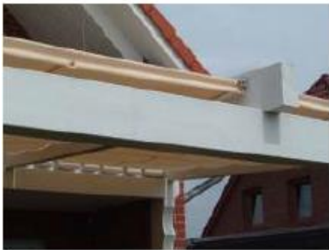
Montage zwischen die Sparren
